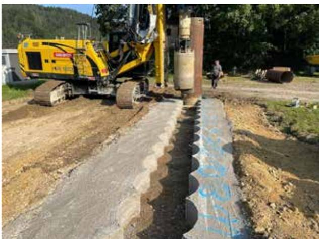
Bei dem errichteten Brunnen handelt es sich um einen Horizontalfilterbrunnen mit einer Filterstrecke von 10 Metern und einer bewilligten Entnahmemenge von 60 Liter pro Sekunde. Beim Bau wurde bereits eine zweite Filterstrecke eingeplant und vorbereitet.
